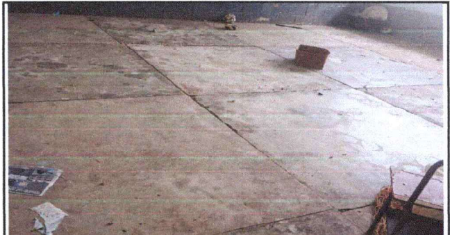
Foto 2: Sustitución de piso por grietas y levantamiento, se aplicara un piso liso nuevo.
