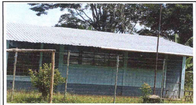
Foto 3: Elaboración de canales de metal para aguas pluviales
